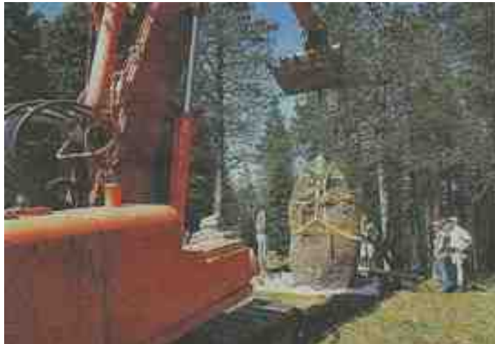
La retroexcavadora manipuló con facilidad el gran bloque. © AITOR ZABALA
